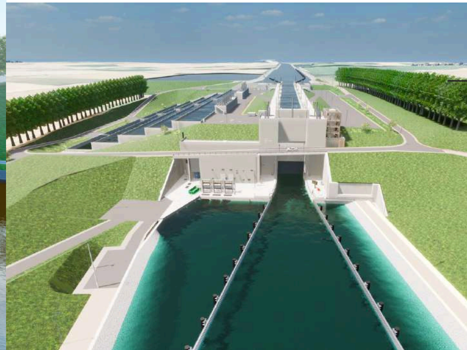
L'écluse d'Oisy-le-Verger, dernière étape à franchir au nord du canal avant de rejoindre l'Escaut en venant du sud, est l'une des plus imposantes du tracé, avec une hauteur de chute d'eau de 25 mètres, un sas de 12,5 mètres de large sur 197 mètres de long. Elle est conçue pour accueillir le public et devenir un spot incontournable des circuits touristiques en Hauts-de-France. © SCSNE
